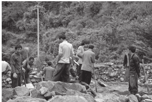
以工代賑関連の工事現場（雲南、2009年筆者撮影）
