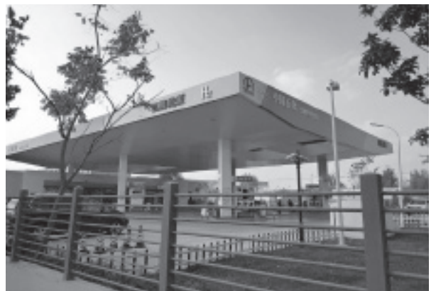
上海嘉定区の混合ステーション
