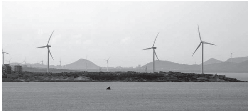
再生可能エネルギーへのシフトが進んでいる（福建省の水上風力発電）
