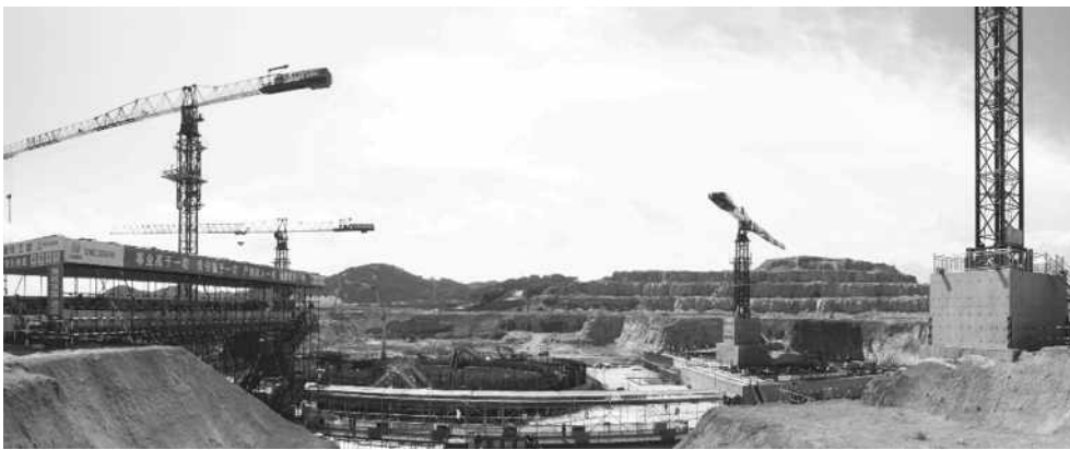
漳州原子力発電所、正式着工直前の状況 (福建省漳州市、19年6月28日筆者撮影)
