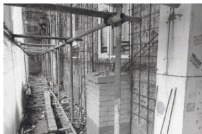
外壁の補修、補強の改修（17年北京にて）
