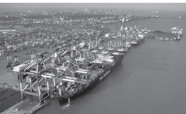
ガントリークレーンが並ぶ巨大港湾である青島港
