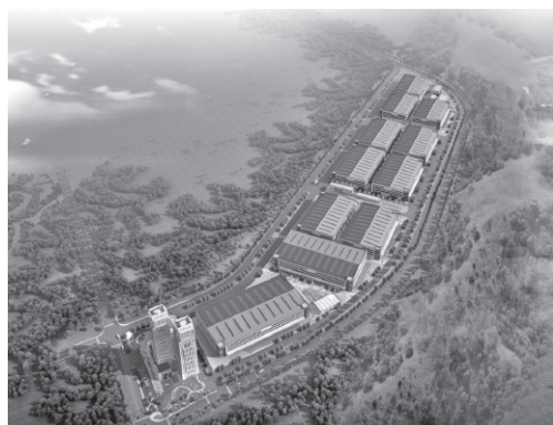
今年9月に竣工予定の青島西海岸新区物流センター
