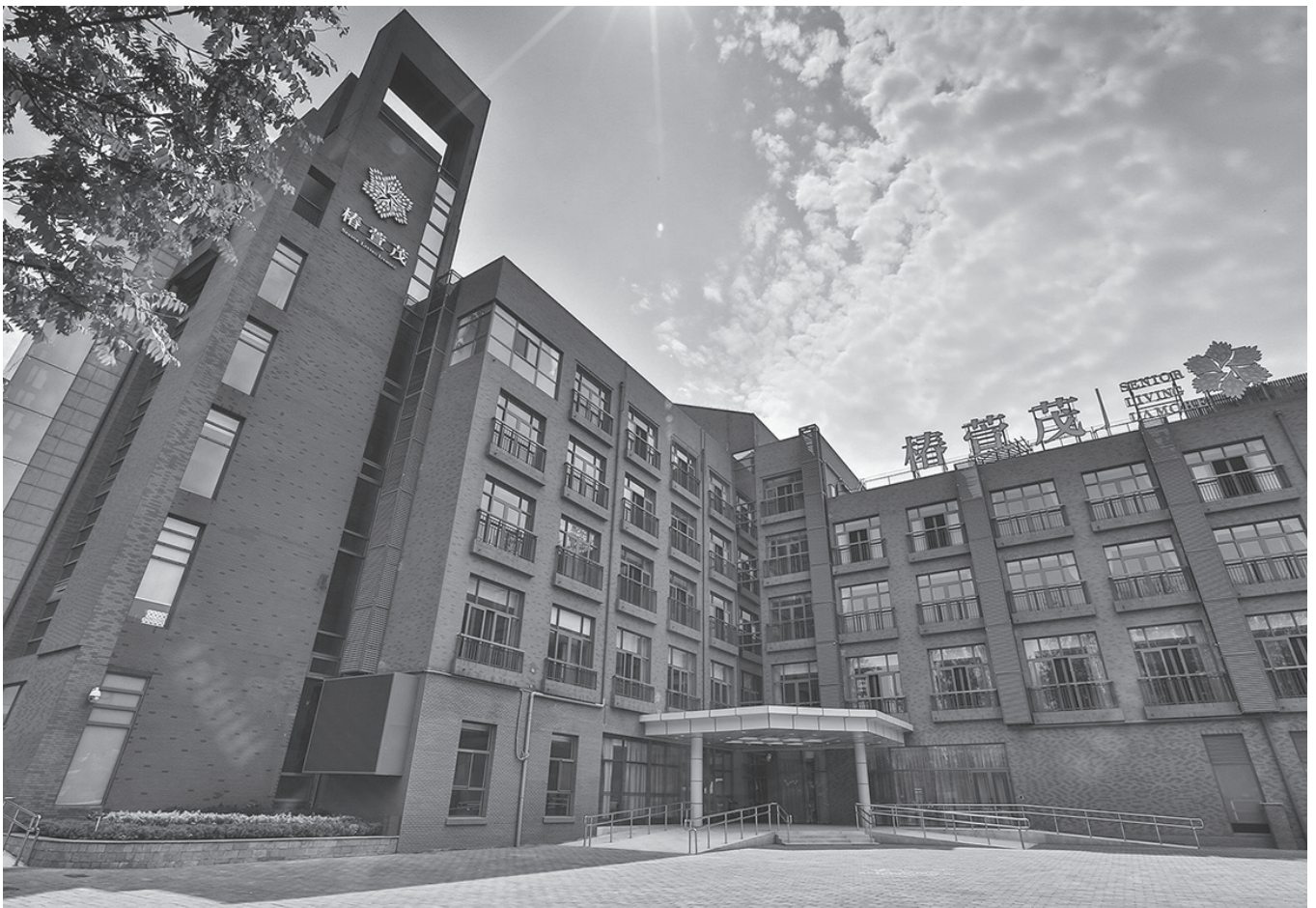
中国の養老院「椿萱茂」の外観
