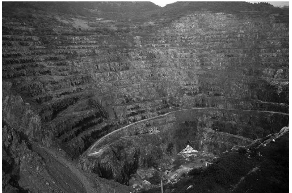
中国最大の露天掘り鉄鉱山・大冶（湖北省黄石）の「天坑」。歴史は呉の時代、3世紀に遡るが、19世紀末に湖広総督譚嗣同により機械化、20世紀初頭からは八幡製鉄所の操業も支えた。最盛期は過ぎたものの、現在も採掘が行われている。深さ450メートル。
