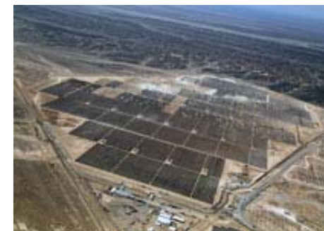
Shams Ma'an太陽光発電所の俯瞰図
